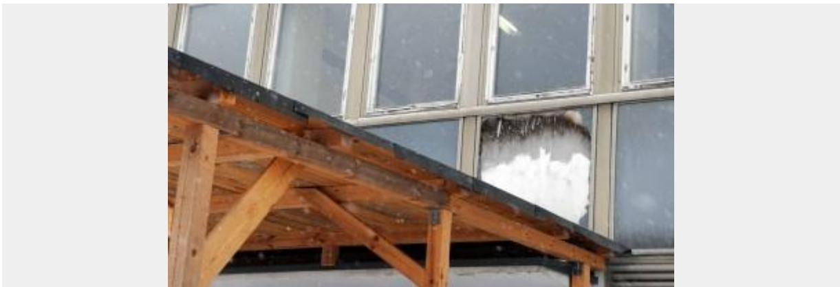
Ufuk D. Ucta . Bild 4 von 4 Löcher in den Fenstern sind mit Pappe abgedichtet
